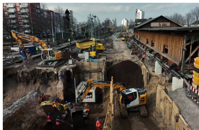
MODERNISATION DE LA GARE BONN RHEINAUE (ALLEMAGNE)
