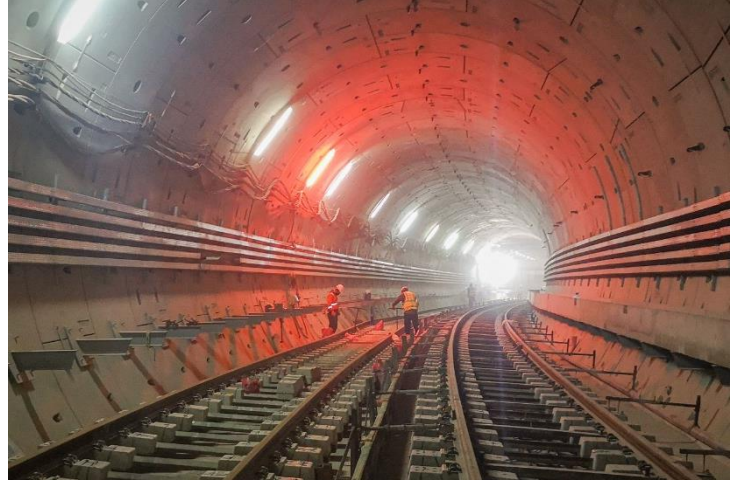
Chantier de la ligne 3 du métro au Caire
