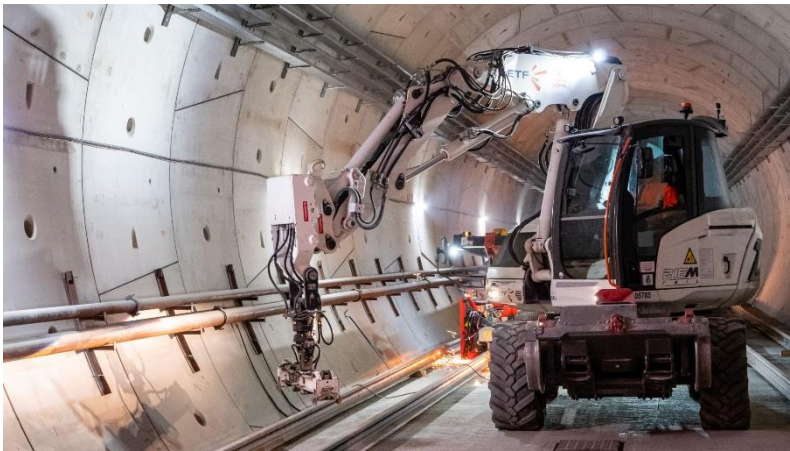
Chantier de la future ligne 15 Sud
