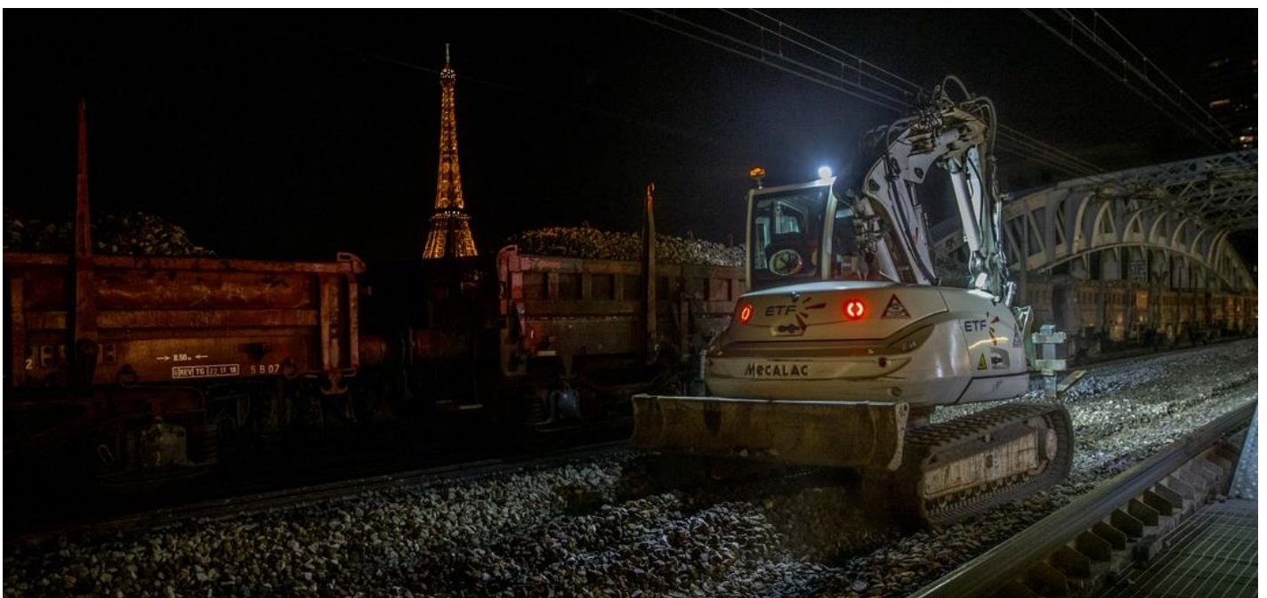
Chantier du RER C
