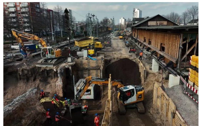
MODERNISATION DE LA GARE BONN RHEINAUE (ALLEMAGNE)
