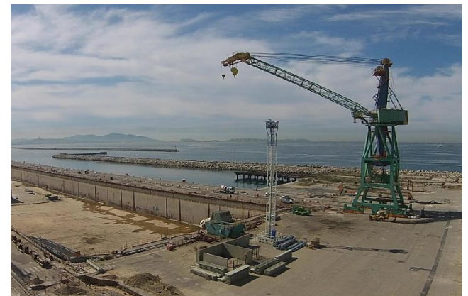
MAINTENANCE DES INFRASTRUCTURES FERROVIAIRES DU GRAND PORT MARITIME DE MARSEILLE
