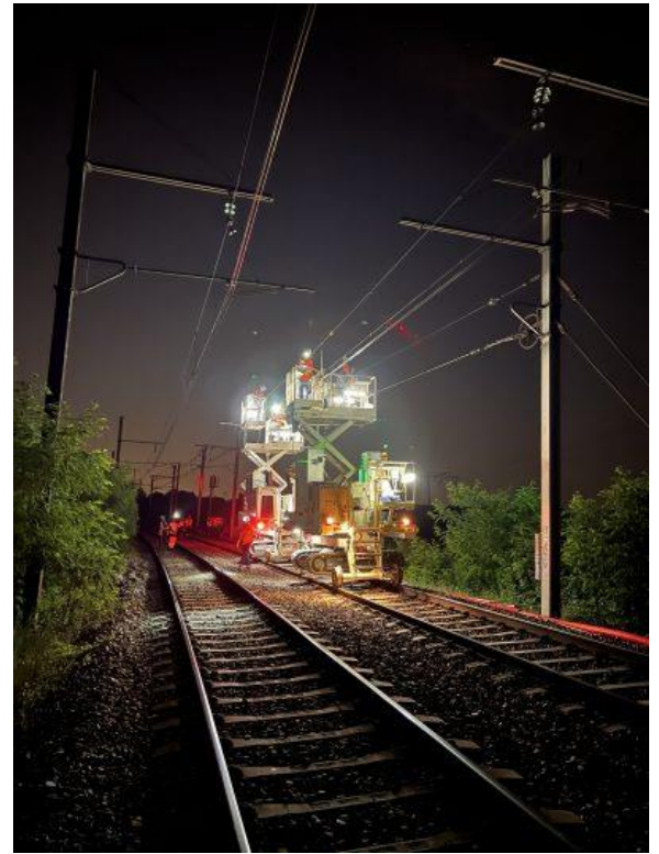
RENFORCEMENT DE CATÉNAIRES SUR LA LIGNE DU RER D
