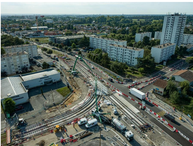
CONSTRUCTION DE L'EXTENSION DE LA LIGNE A DU TRAMWAY BORDELAIS JUSQU'À L'AÉROPORT DE MÉRIGNAC
